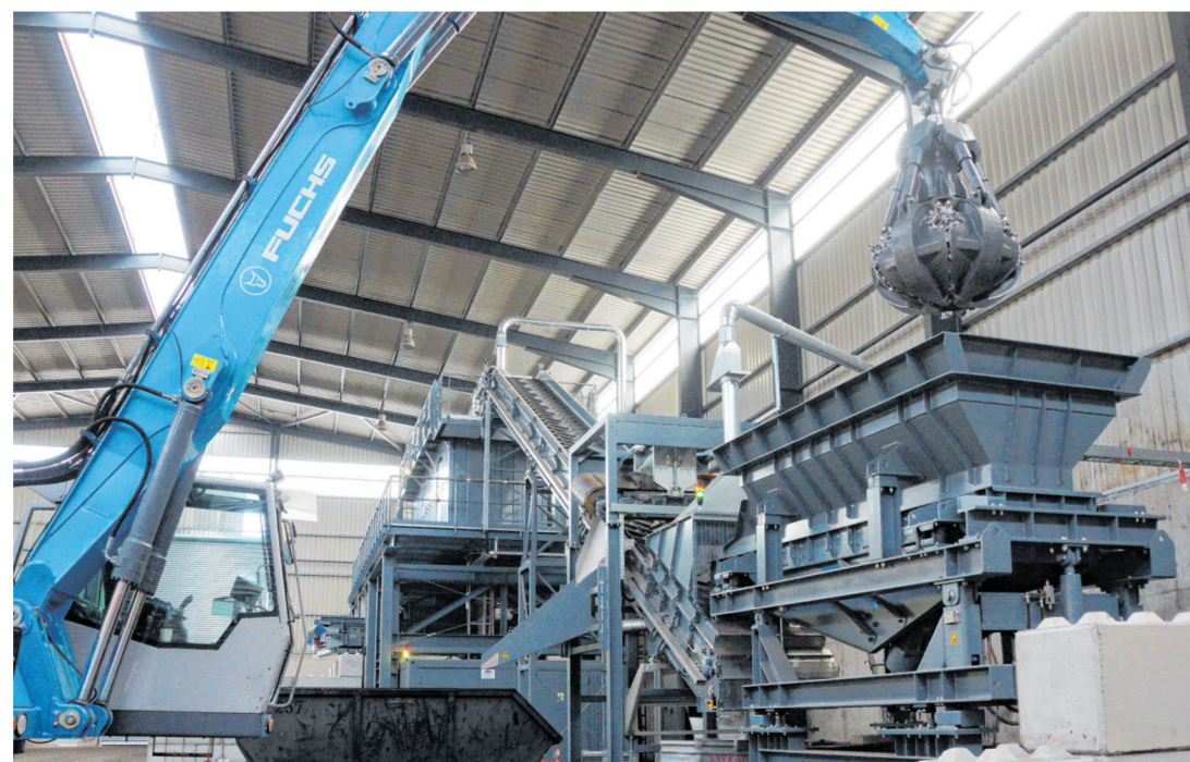
Befüllung der Anlage
